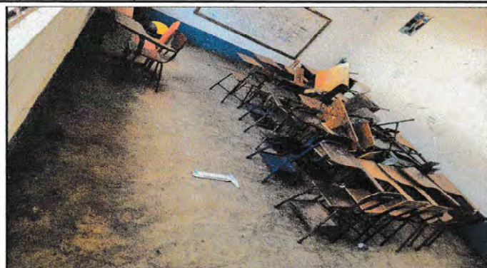
Foto 1: El piso de torta de concreto desde su construcción no tenido cambios. Sus medidas son largo 8 mt y ancho 5 mt
