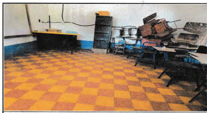
Foto 5: se necesita un cambio de piso de mejor calidad ya que el que está no llena los requisitos de un salón de clases. Sus medidas son largo 4 mt y ancho 5 mt
